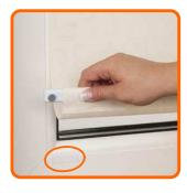
Schritt 8: Kleben Sie die Magneten auf den innen liegenden Fallstab des Rollos und die Magnetklebestreifen auf den Fensterrahmen.
