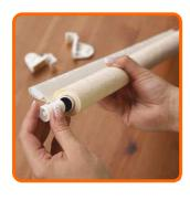
**Schritt 5:**Setzen Sie das Endlager auf der anderen Seite in die Welle des Rollos ein.
