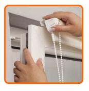
Schritt 6: Entfernen Sie die 2. Folie des Klebebandes und setzen Sie die Klemmträger auf den Fensterrahmen.
