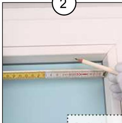
Positionierung der Träger markieren
