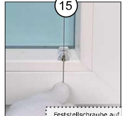
Feststellschraube auf Höhe des Spannschuhes fixieren
