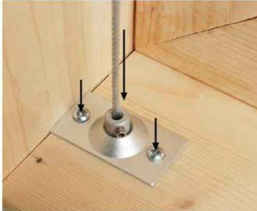
Ziehen Sie den Draht durch das Loch der Feststellschraube und fixieren Sie den Draht mit dem Imbusschlüssel. Erst dann, schrauben Sie den Spannbock zum Spannen am Boden fest..
