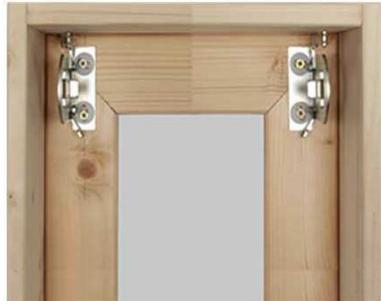
Damit das Rollo später bei der Benutzung gerade auf- und abwickelt, ist es erforderlich, dass die Rolloträger absolut waagrecht montiert werden. Benutzen Sie hierfür bitte eine Wasserwaage.
