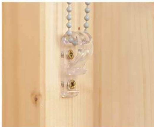
Fädeln Sie die Kette durch den Kettenhalter, markieren Sie die Bohrlöcher und schrauben Sie den Kettenhalter fest..
