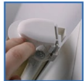
Schritt 8: Klemmen Sie das Doppelrollo bei angeklapptem Fenster auf den Fensterflügel. Denken Sie dabei an die Klebestreifen.
