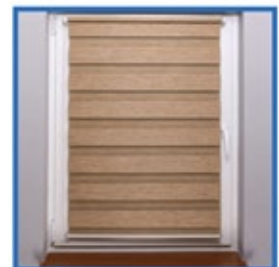
Schritt 8: Klemmen Sie das Doppelrollo bei angeklapptem Fenster auf den Fensterflügel. Denken Sie dabei an die Klebestreifen.
